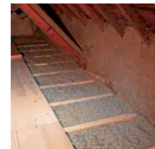
Dämmung oberste Geschossdecke
