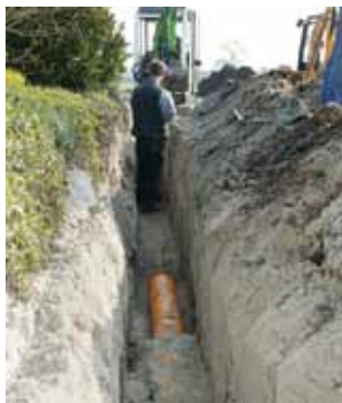
Lufterdwärmetauscher
