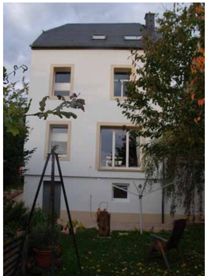
Nach Sanierung mit Außenwanddämmung
