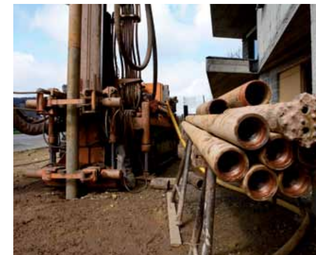
Erdsondenbohrung für Wärmepumpe
