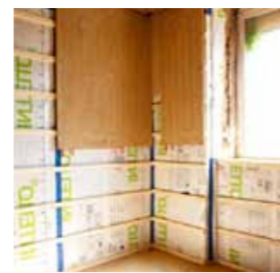
Beispiel einer Innendämmung: Zelluloseflocken (feuchteadaptive Dampfbremse)
