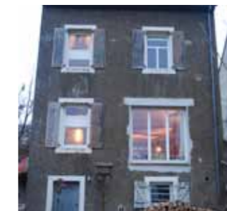
Vorher: Gartenfassade ungedämmt
