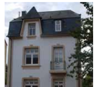
Nachher: Straßenfassade mit Innendämmung
