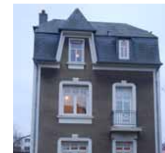
Vorher: Straßenfassade ungedämmt
