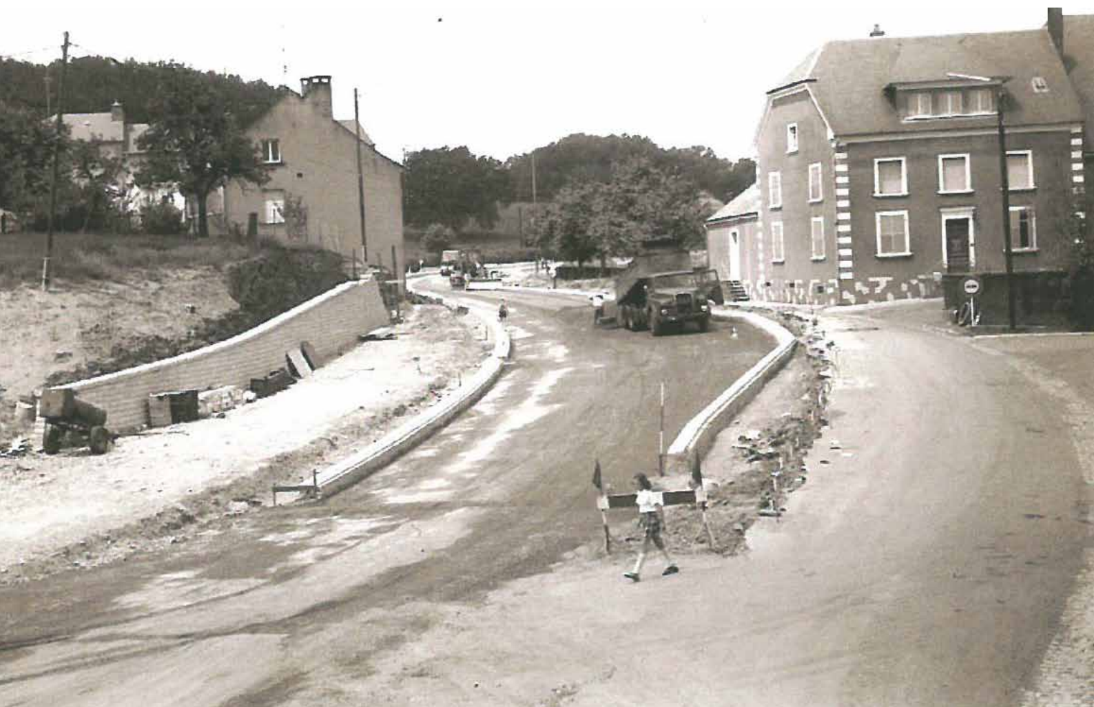
CONSTRUCTION "RUE DES 3 CANTONS" 1975
