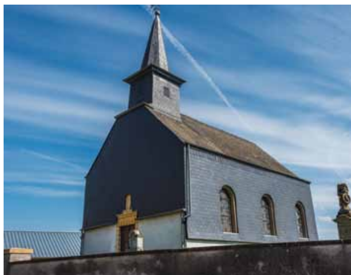
ÉGLISE À DAHLEM rue de l'École | L-8352 Dahlem
