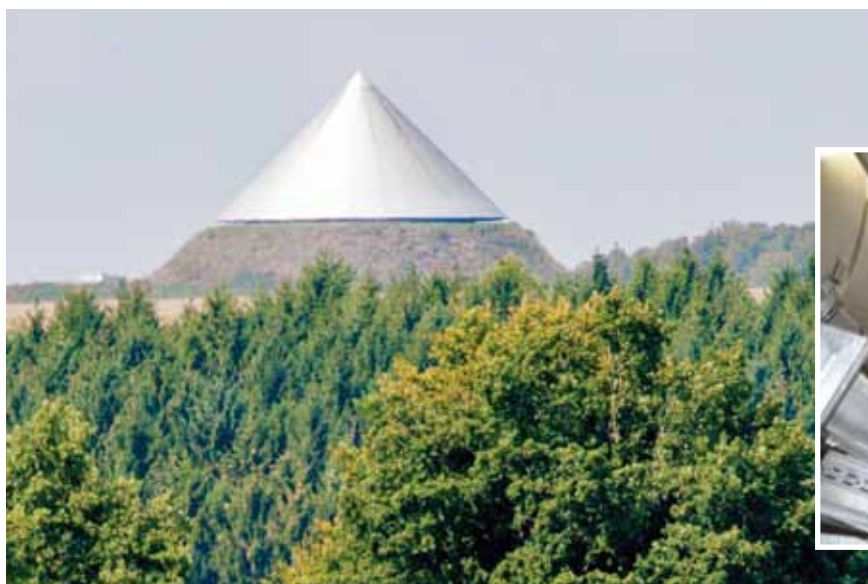
CHÂTEAU D'EAU AU "RÉIBIERG"
