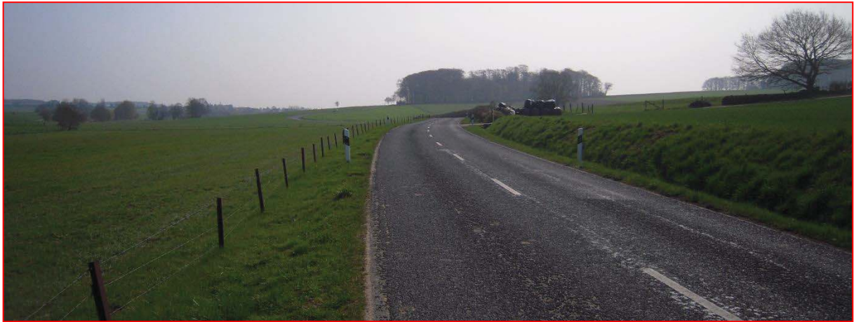
Intégration paysagère insuffisante du CR101 entre Garnich et Holzem.
