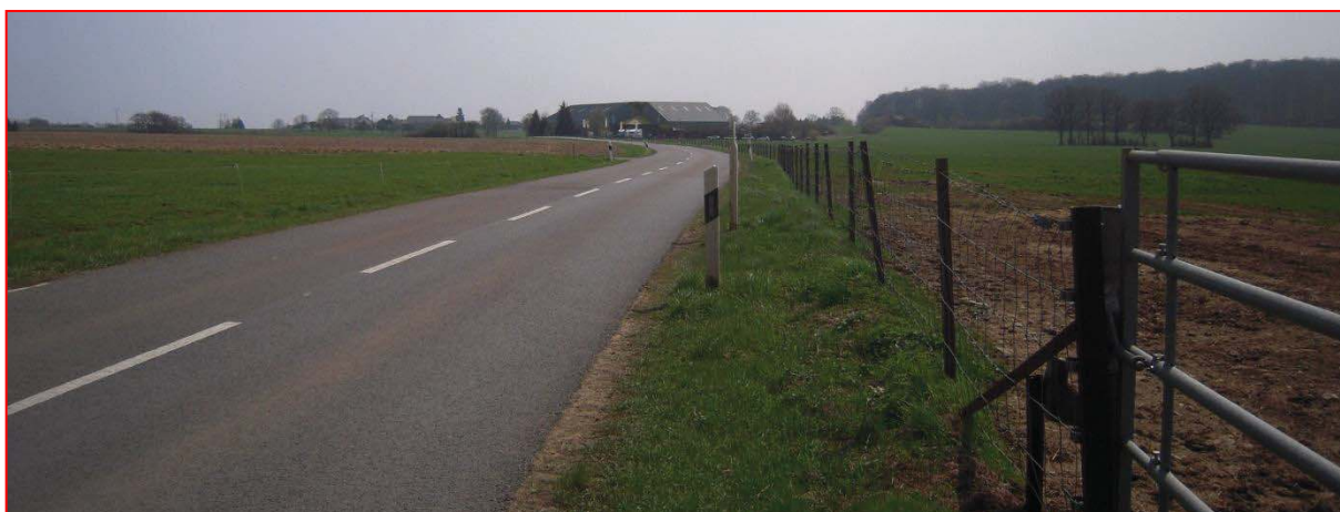
Entreprise de toiture en zone verte entre Hivange et Dahlem, dont l'intégration paysagère est insuffisante.
