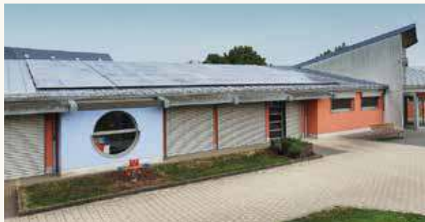
D' PV Anlag um Daach vun der Schoul Duelem // La centrale photovoltaïque sur le toit de l'école à Dahlem
