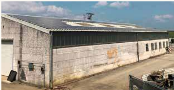
D' PV Anlag um Daach vum Atelier Communal zu Garnech // La centrale photovoltaïque sur le toit de l'Atelier Communal à Garnich
