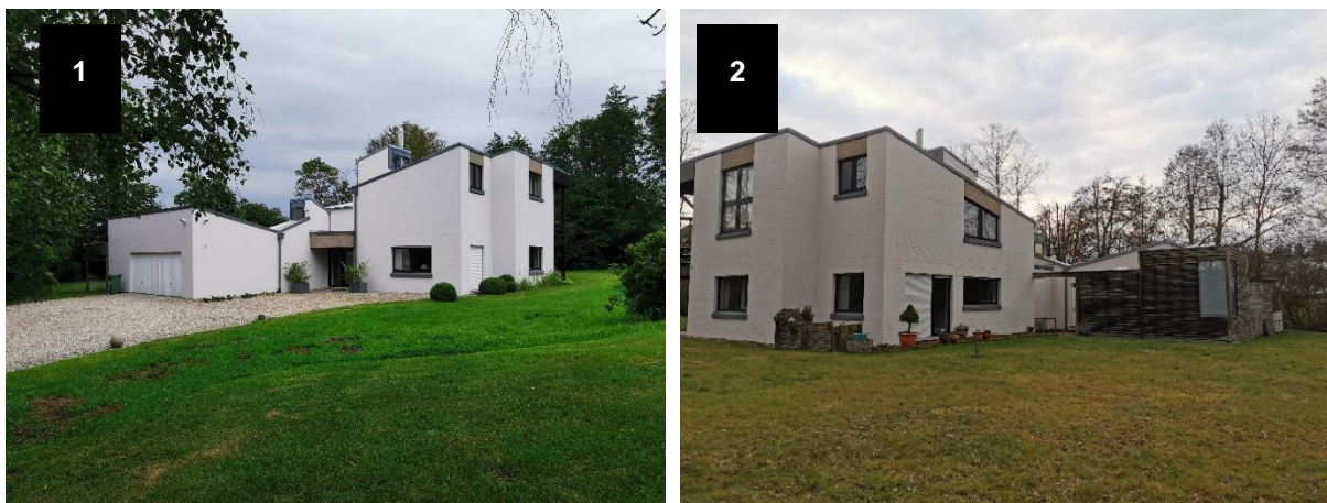
Vue de la maison existante depuis l'accès
