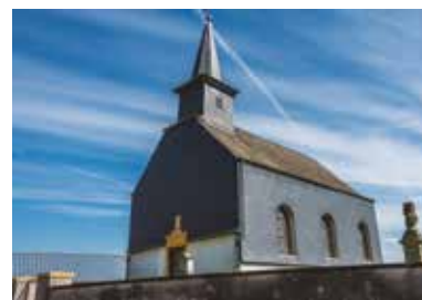
Église à Dahlem rue de l'École | L-8352 Dahlem
