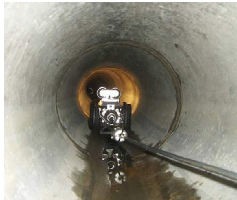
Inspection caméra canalisation et remise en état
